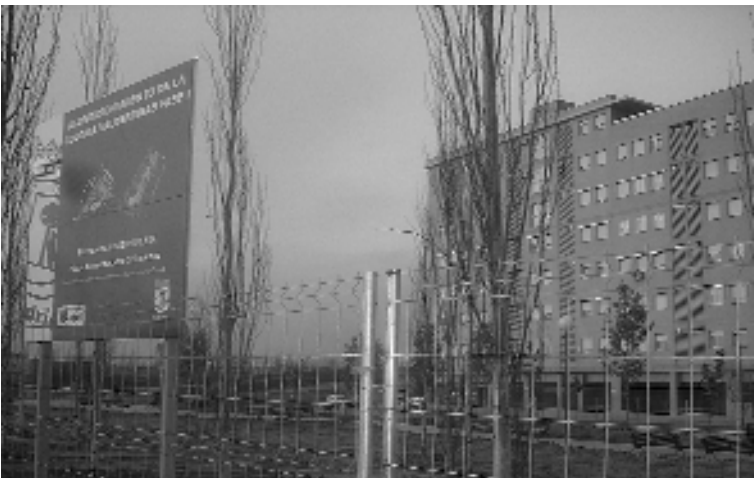
Arriba Parque Forestal. Abajo obras en zonas verdes de Valderribas.
