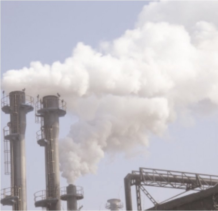
Chimeneas de la Central Térmica de Huelva.
